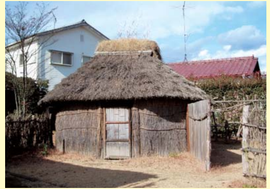
復元された平地建物（群馬県渋川市 中筋遺跡） 地面を床にした建物です。壁で屋根を支え、内部に柱はありません。小型で簡単な造りです。竈があるので、住居でしょう。倉庫などに使用されたものもありました。
