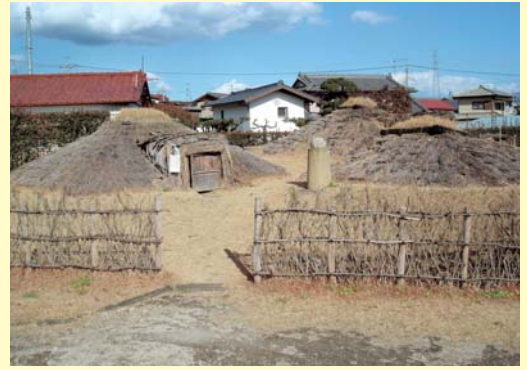
復元された6世紀の村（群馬県渋川市 中筋遺跡） 地面を掘り下げた土を家の周囲に土手状に盛っています。屋根は低く、草葺の上に土を塗り、さらに草で覆っています。
