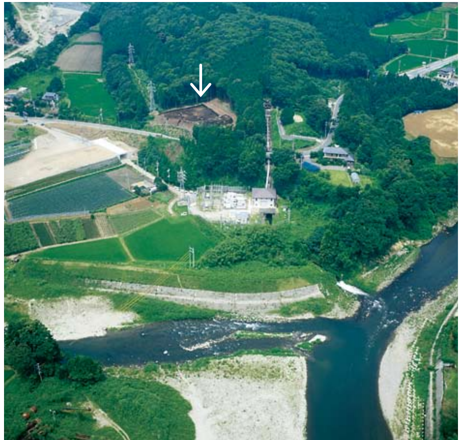
全景空撮写真(南東から)
