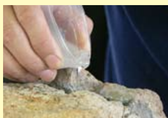
亀裂に樹脂を流し込む (写真 7)
