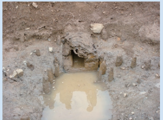
江戸時代の暗渠排水用木樋出土状況
