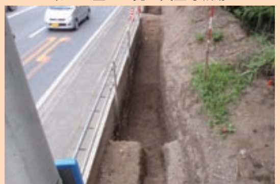
歩道拡幅部分の調査区
